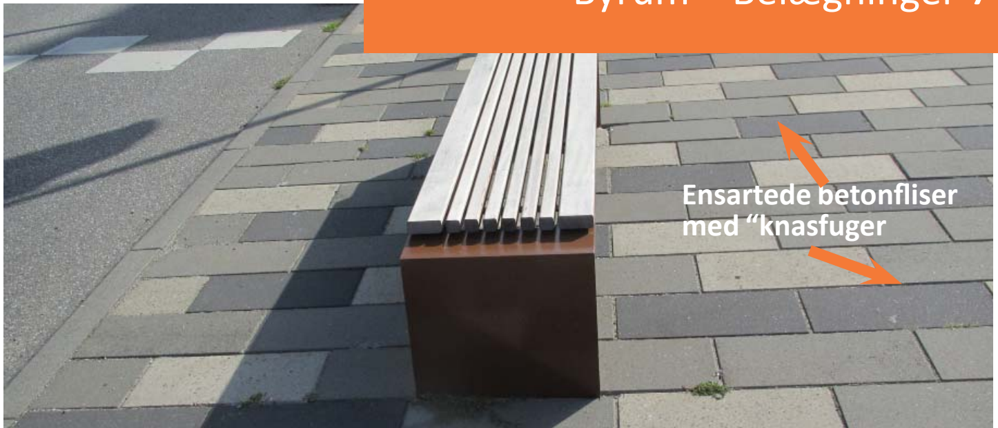
Thyborøn - Bredgades belægning består af betonfliser med grov overflade, som virker skridhæmmende.
