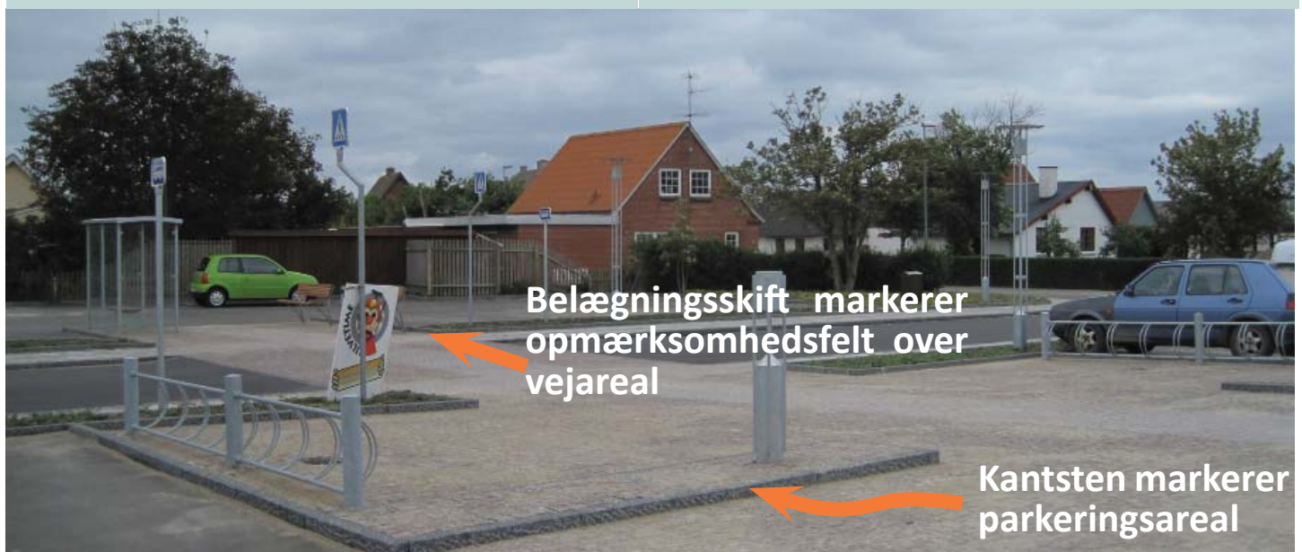
Harboøre - Kirkepladsen er belagt med skårne chaussésten med "knasfuger", parkeringsarealer er markeret med hævet kant. Belægningen fortsætter som opmærksomhedsfelt over kørebanen.
