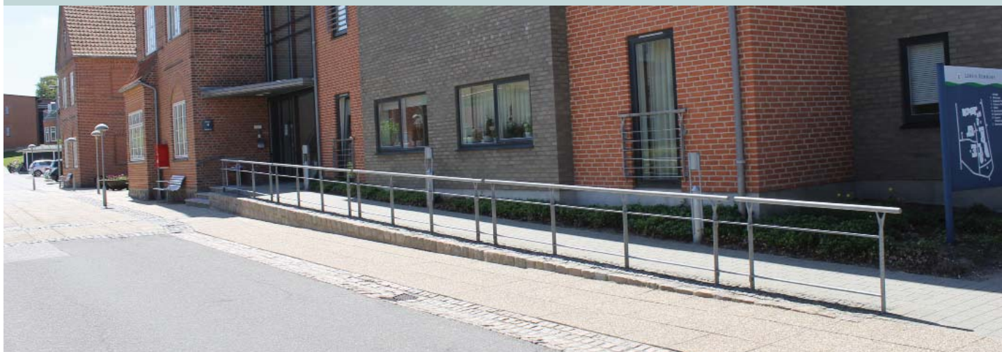
Lemvig - Rampe ved plejehjemmet, integreret som en del af fortorvet, belagt med skridsikre betonsten.
