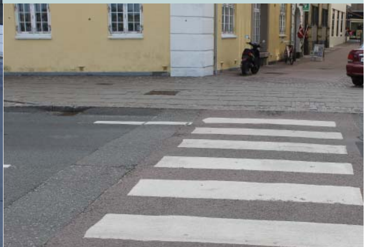
Lemvig - Fodgængerfelt mellem havnen og sidegade til gågaden. Kantsten udlignet, belægningsskift for opmærksomhedsfelt.
