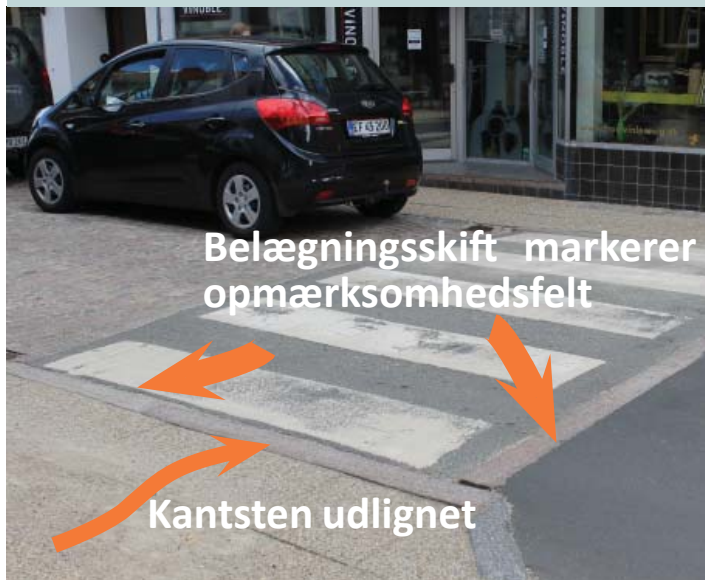
Lemvig - Fodgængerfeltet ved Vasen er markeret ved belægningsskift og kantstenen er nedsænket.
