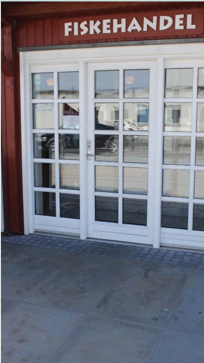
Thyborøn - Niveaufri adgang integreret som del af belægningen med betonfliser og kantsten ved fiskehandel på havnen.
